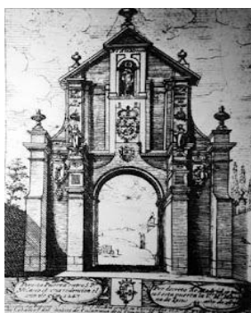
Antigua puerta de Alcalá
